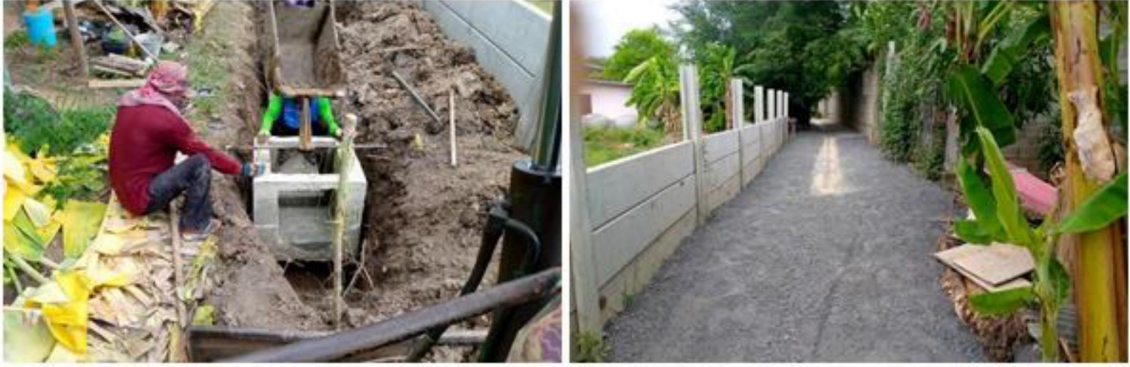
๑๔.โครงการก่อสร้างวางท่อระบายน้ำค.ส.ล. หมู่ที่ ๑ บริเวณร้านซ่อมรถจักรยานยนต์
