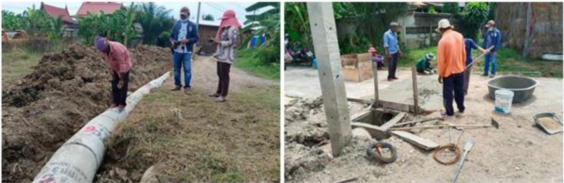
๑๕.โครงการก่อสร้างวางท่อระบายน้ำค.ส.ล. หมู่ที่ ๓ ริมคลองประดู่
